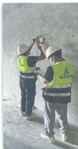
电阻检测现场
